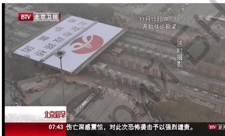
Рисунок 1 – Передвижение заранее смонтированного нового пролетного строения мост
