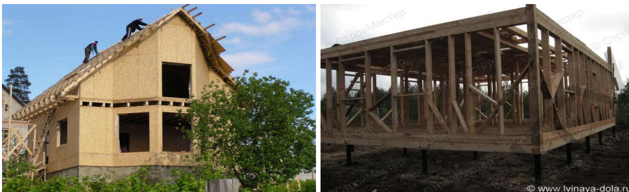
Рисунок 2 – Возведение каркасных домов
