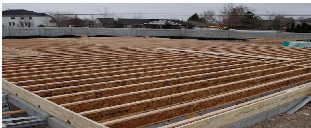
Рис. 1. Система перекрытий из деревянных двутавровых балок
