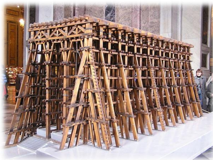
Рисунок 1. Модель лесов, применявшихся для подъёма колонн
