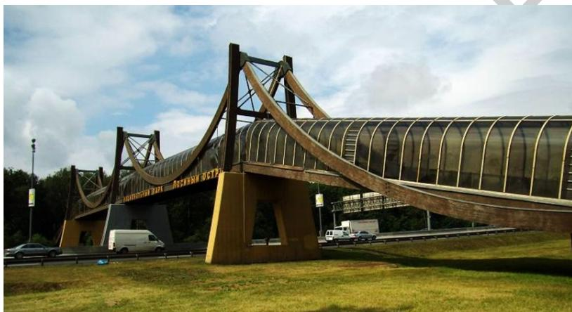
Рисунок 1 – Применение kleеной древесины в мостостроении
