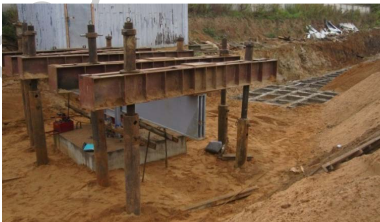
Рисунок 1 – Опытная установка на армированном грунте (в правой части видны бетонные армирующие решетки)
