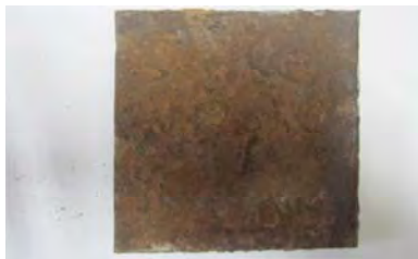
Рис. 1.10. Фотография поверхности образца (материал – Ст3), подвергнутого процессом речной и атмосферной коррозии; образец вырезан из обшивки корпуса судна (на уровне ватерлинии), проходящего ремонт на ОАО «Пинский ССРЗ»
