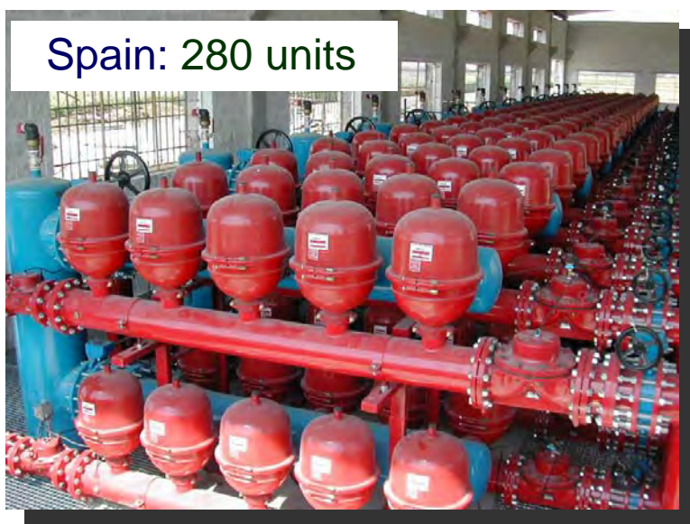
Рис. 3.2 Система дисковой фильтрации «Аркал»
