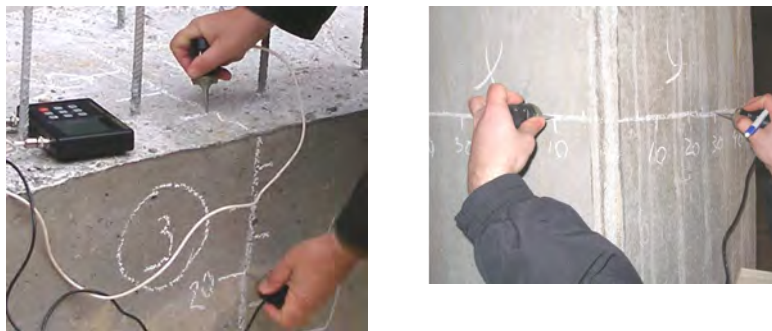
Рис. 6.18 – Испытания ростверка и колонны ультразвуковым методом профилирования
