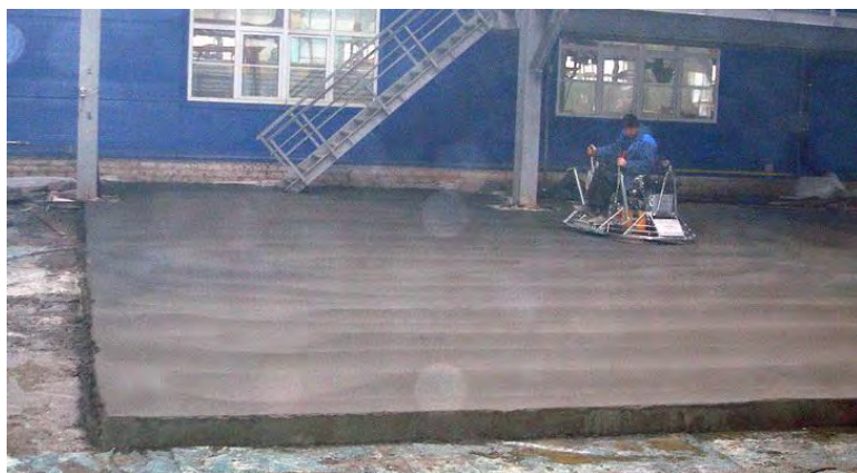
Рис. В.1 – Нанесение упрочняющего покрытия бетонного пола
