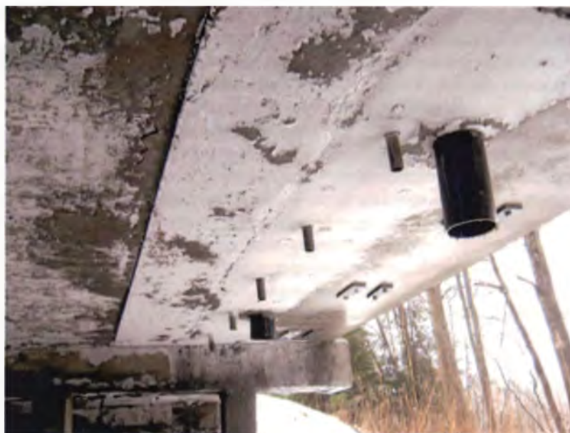
Рисунок 3 – Вид пролетного строения после ремонта моста через р. Диражня на км 61,430 автомобильной дороги М-3 Минск – Витебск
