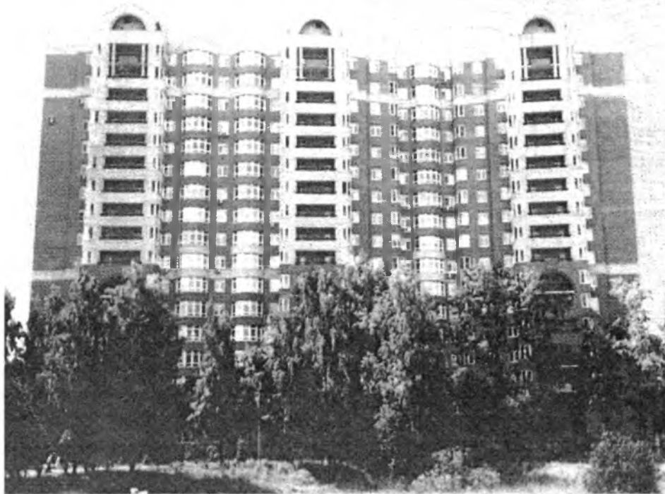
Рис. 1 (к примеру 2.2). Общий вид стеновых конструкций жилого здания
