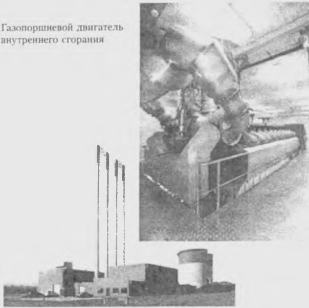
Рис. 3. Мини-ТЭЦ с газопоршневыми двигателями внутреннего сгорания
