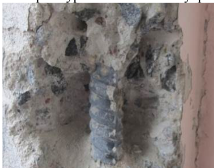
Рис. 1. Фрагмент колонны крайнего ряда
