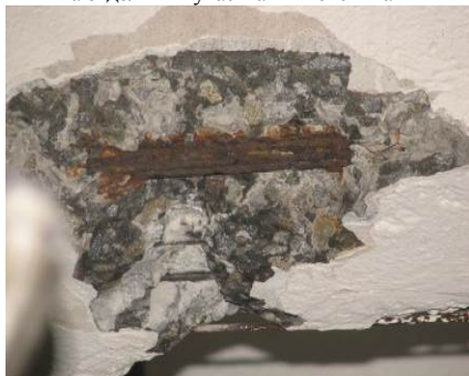
Рис. 4. Фрагмент балки покрытия
