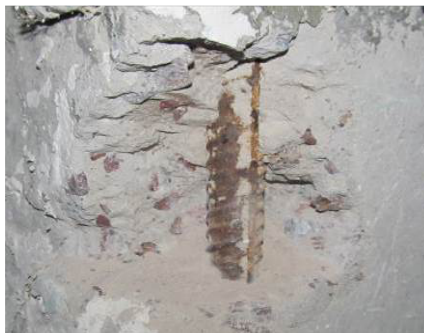
Рис. 2. Фрагмент колонны крайнего ряда
