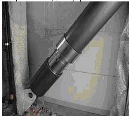
Рис. 4. Жидкостный вязкоупругий демпфер в здании
