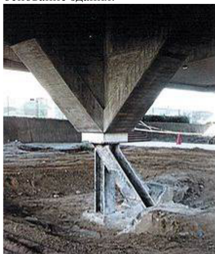
Рис. 5. Реконструкция пяты свода приподнятого основания
