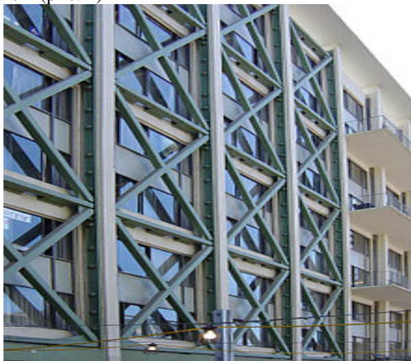
Рис. 1. Наружная антисейсмическая стальная ферма спального корпуса университета Беркли
