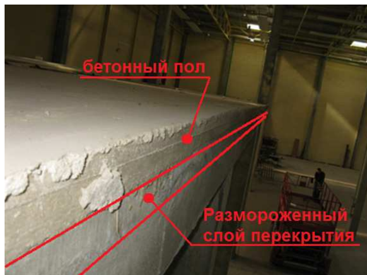
Рис. 1. Общий вид участка усиливаемого перекрытия логистического центра
