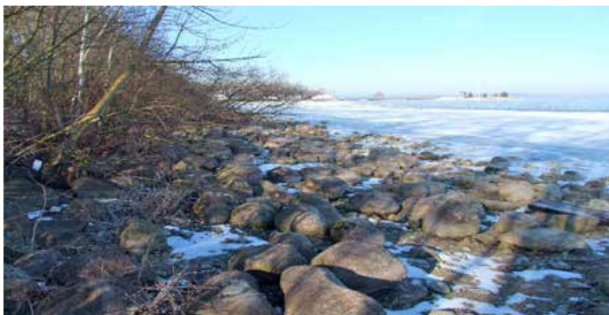
Рис. 10. Искусственная самоотмстка на Заславском водохранилище
