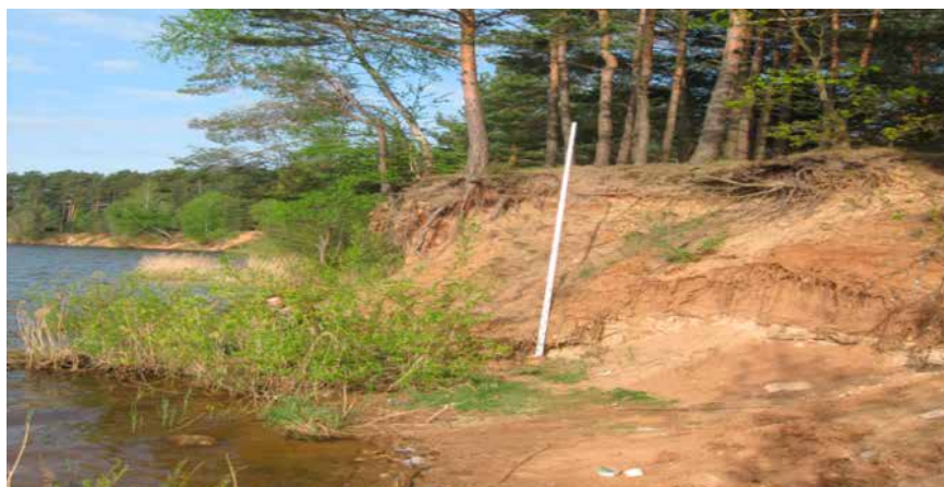
Рис. 1. Вилейское водохранилище. Переработка правого берега (Фото В. Левкевича, 2016 г.)
