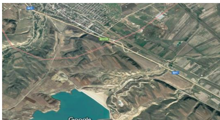
Рисунок 1 – Плотина Тахтакорпюнского водохранилища
