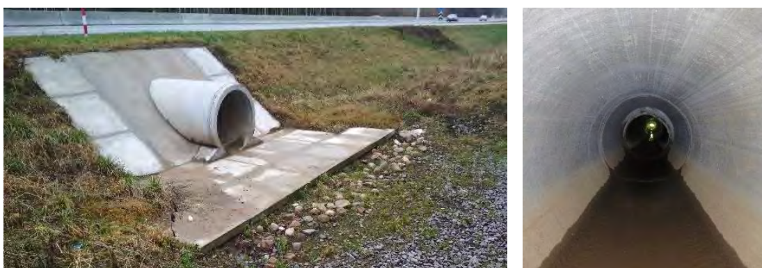
Рис. 3.1. Общий вид водопропускной трубы
