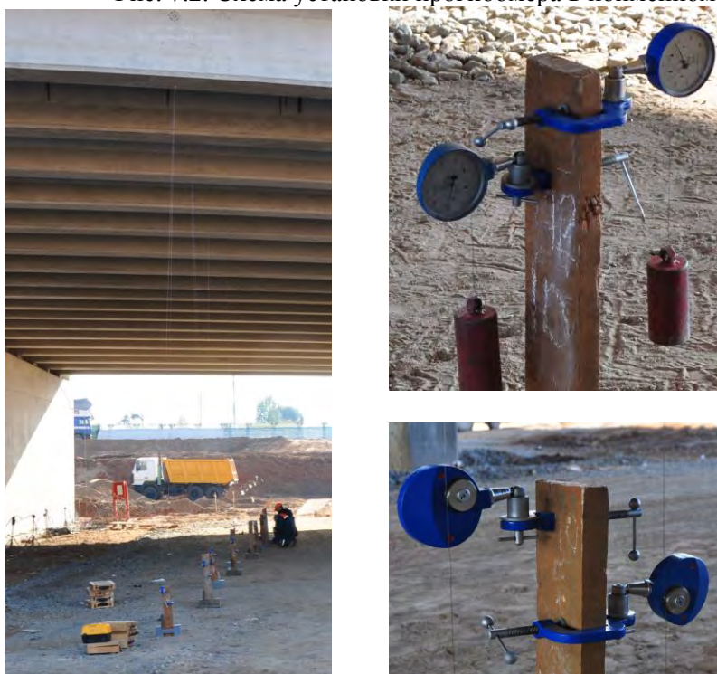
Рис. 7.3. Пример установки прогибомеров ПАО при испытании путепровода
