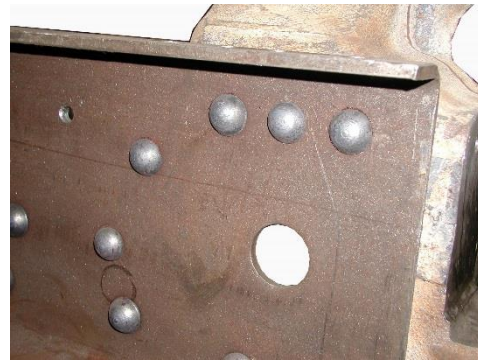
Рис. 2. Заклепочное соединение
