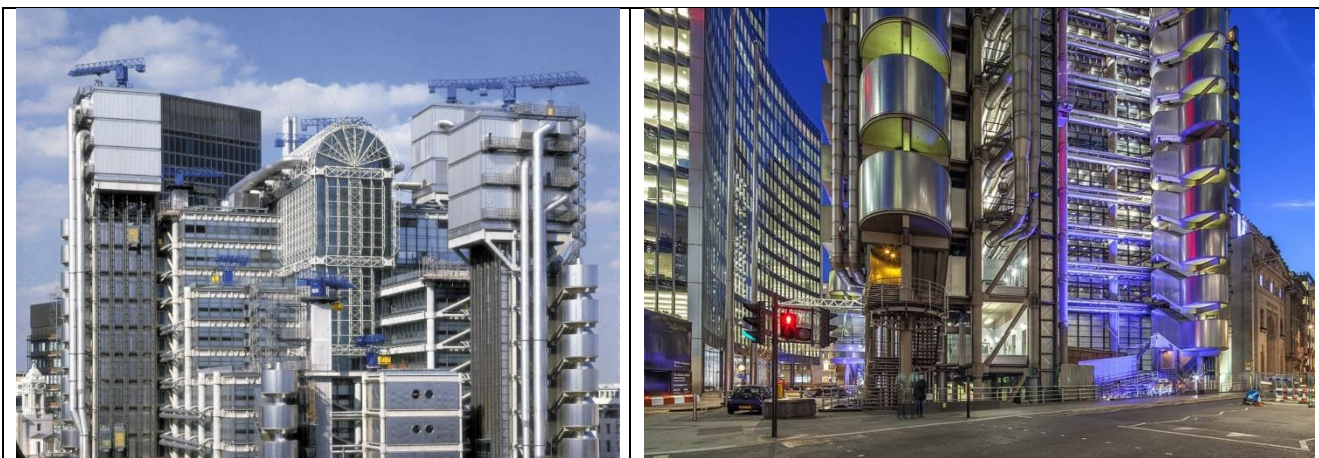
Рисунок 3. Здание страхового рынка Ллойда. Общий вид
