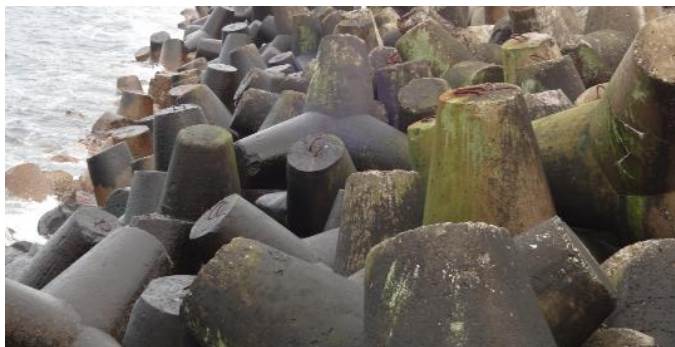
Рисунок 6. Состояние бетона в тетраподах оградительного сооружения X2-1 после 50 лет эксплуатации
