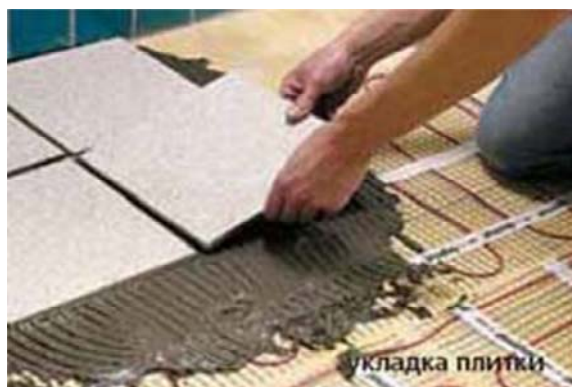
Рис. 21.12. Укладка пола из плитки
