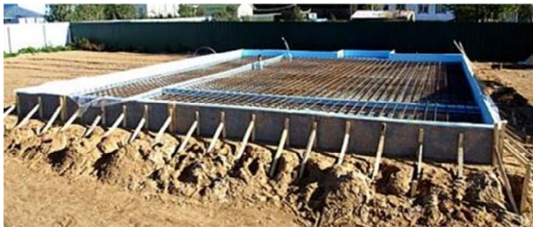
Рис. 11.6. Подготовленная к укладке бетонной смеси опалубка с арматурными каркасами
