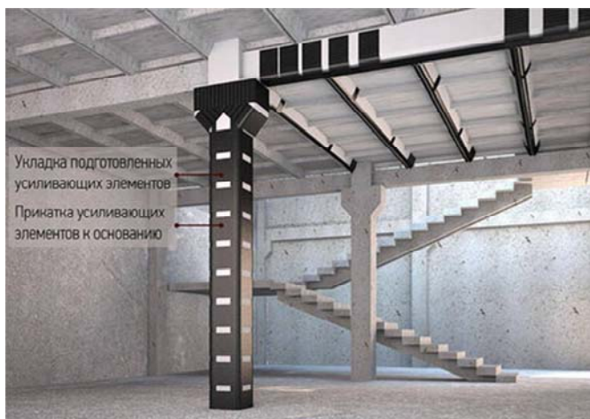
Рис. 6.35. Железобетонные конструкции, усиленные по технологии СВА
