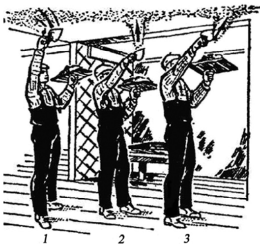
Рис. 17.6. Нанесение раствора на потолок набрасыванием:
