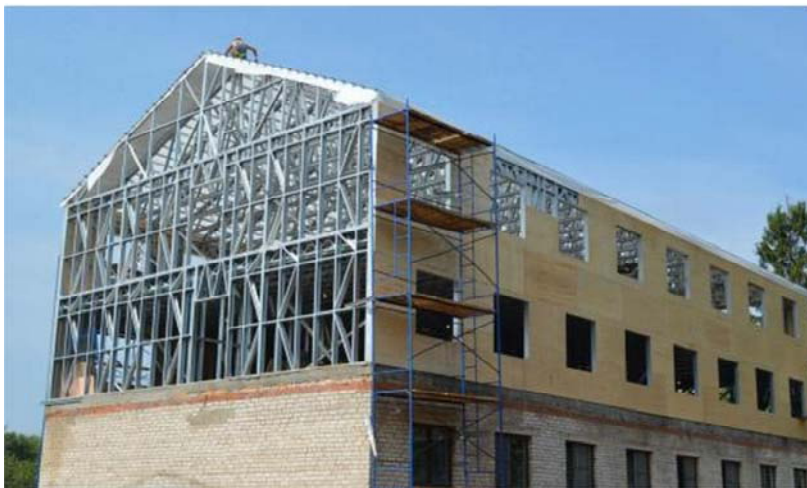
Рис. 14.26. Реконструкция (надстройка этажей) здания с применением ЛСТК
