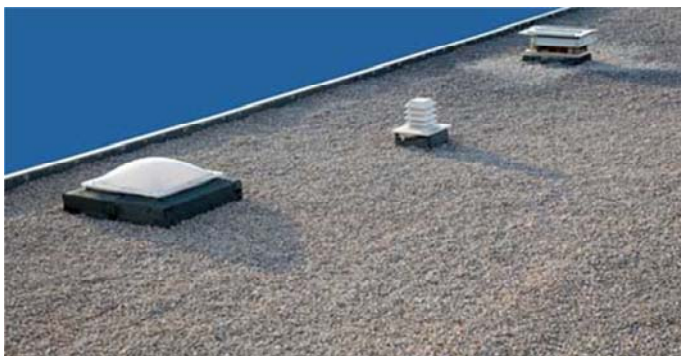
Рис. 15.14. Балластная полимерная кровля
