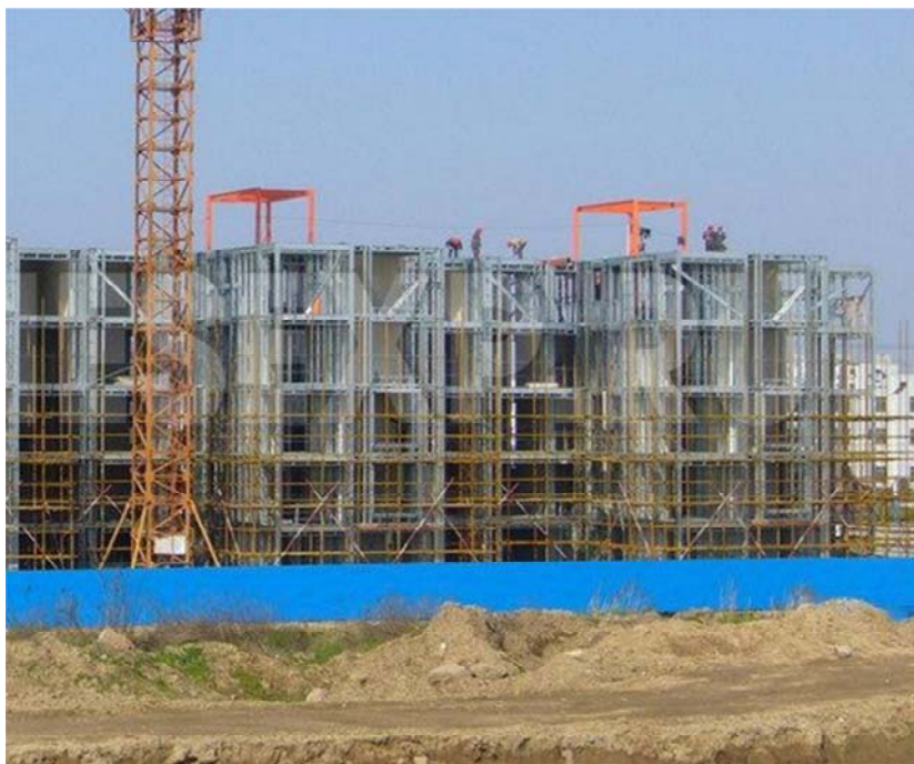
Рис. 14.19. Несущий каркас жилого здания из ЛСТК
