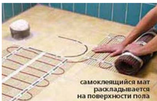
Рис. 21.10. Укладка электрических нагревательных матов
