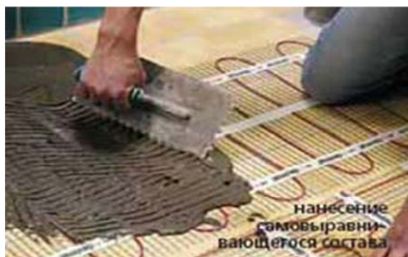
Рис. 21.11. Устройство стяжки под полы
