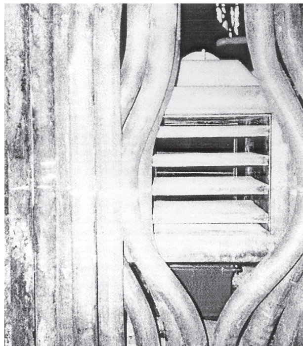
Рис. 1. Вид горелочного устройства из точки котла
