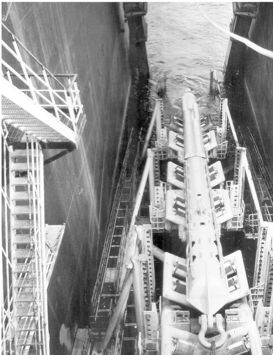
*Хорошо заметна специальная защита монтажных стыков. Когда секция закончена, к ней приваривается временная заглушка*
