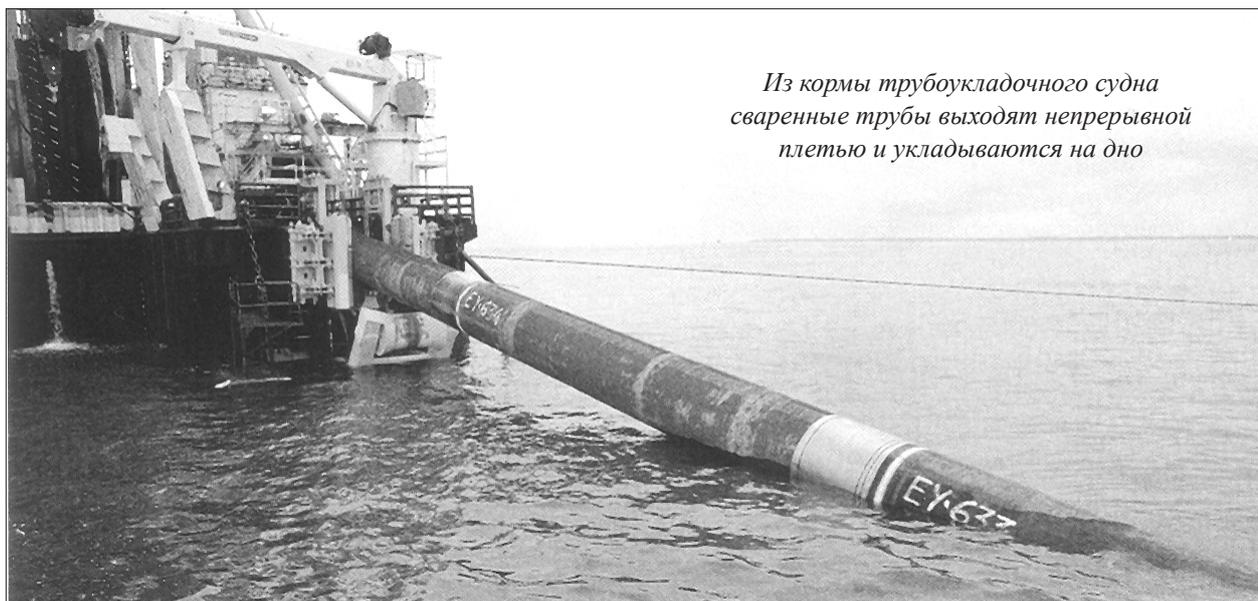
*Из кормы трубоукладочного судна сваренные трубы выходят непрерывной плетью и укладываются на дно*
