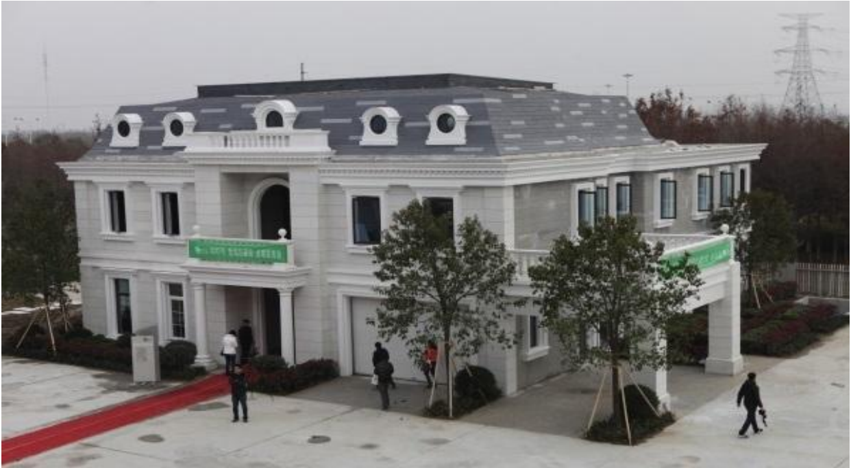
Рисунок 3 - Дома, созданные 3D-принтером компании ВинСун, Китай Источник: собственная разработка авторов на основании [1]
