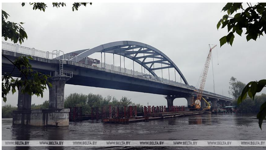
Рисунок 1 – Вид моста сбоку
