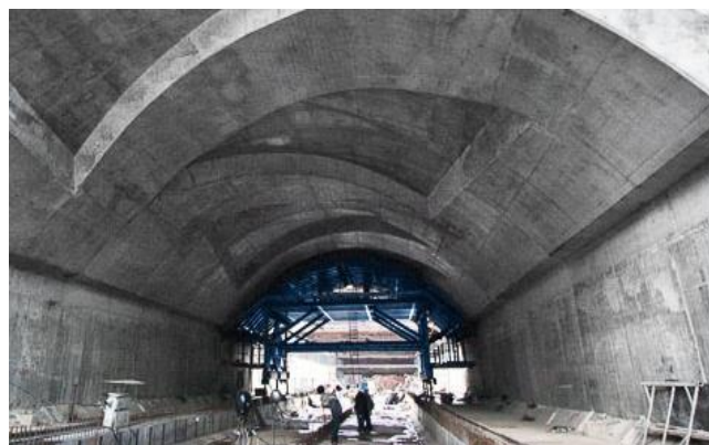
Рисунок 2 – Механизированный опалубочный комплекс СТАЛФОРМ Инт
