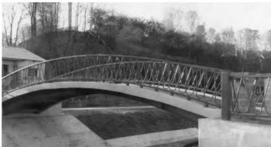
Рисунок 2 – Пешеходный мост в г. Могилеве
