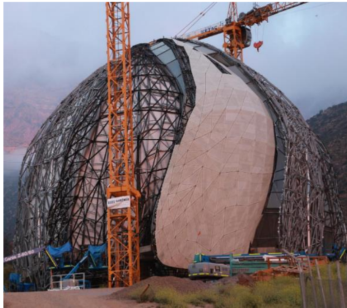
Рисунок 6 – Каркас конструкции с отделанным одним «лепестком»
