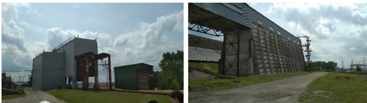
Рисунок 3 – Хранилища для заполнителя
