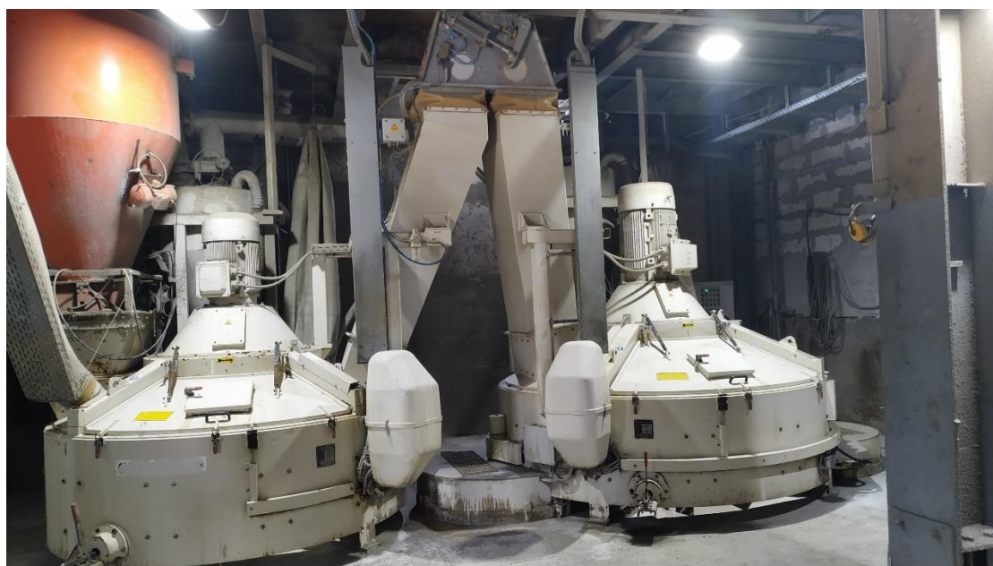
Рисунок 2 – Смесительный цех завода Метрострой
