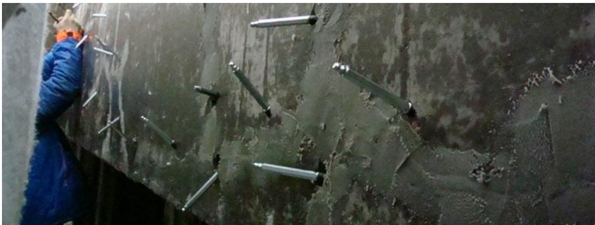
Рисунок 2 – Устройство удлиненных штырей (пакеров) для закачивания инъекционного раствора
