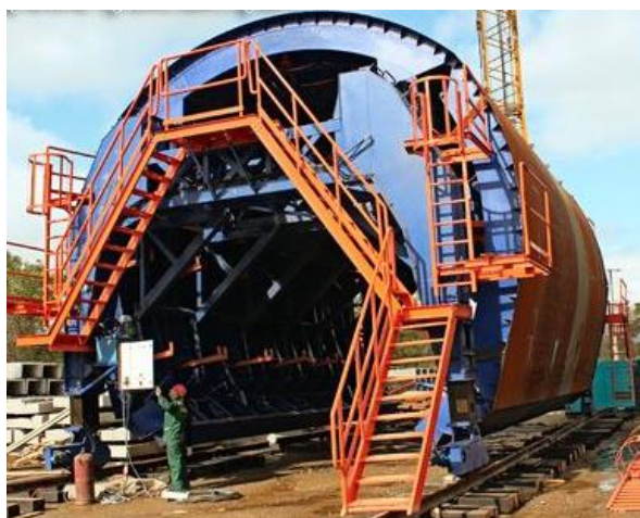
Рисунок 5 – Катучая тоннельная опалубка ПСК
