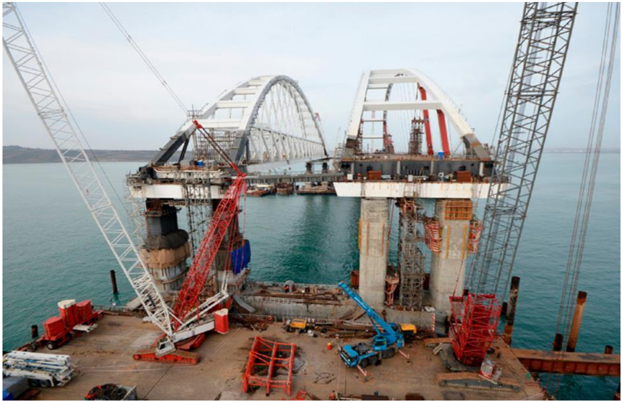
Рисунок 3 – Процесс строительства Крымского моста
