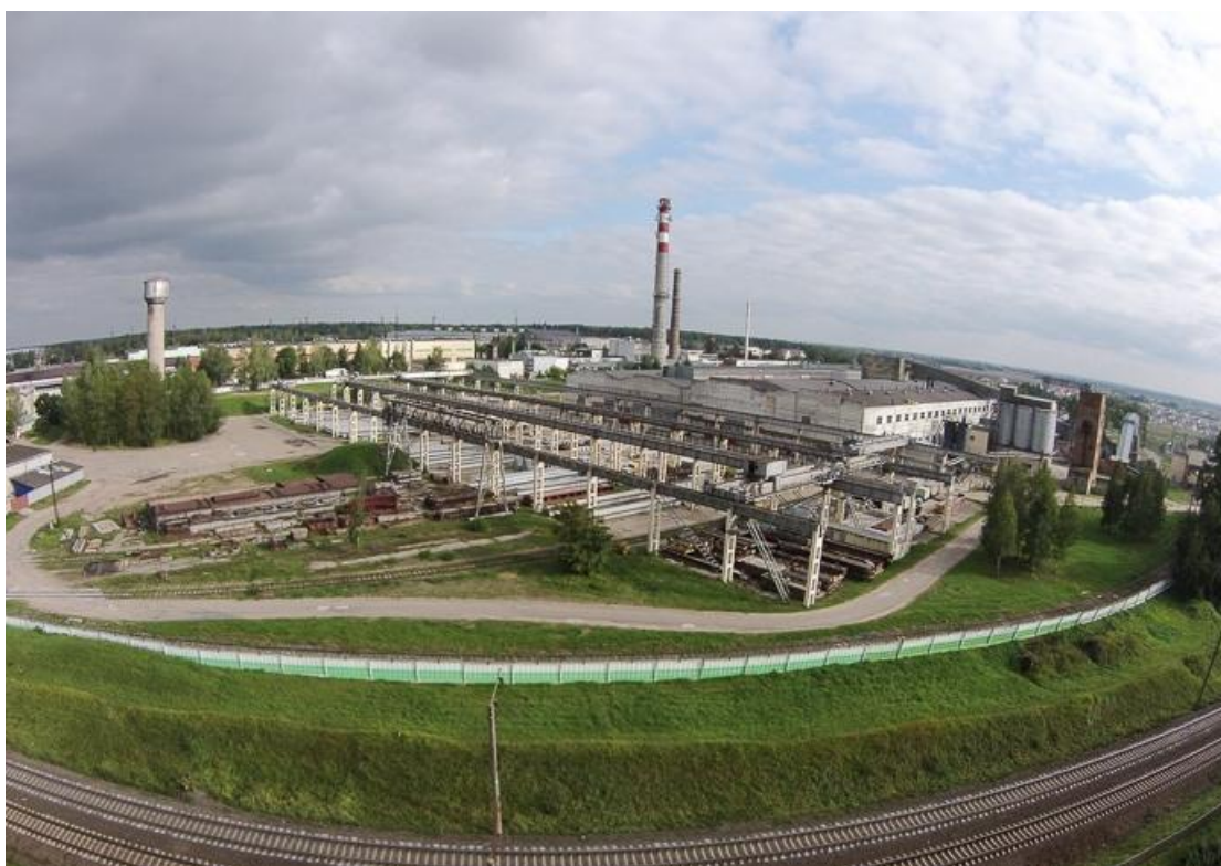
Рисунок 1 – Завод железобетонных мостовых конструкций г.Фаниполь
