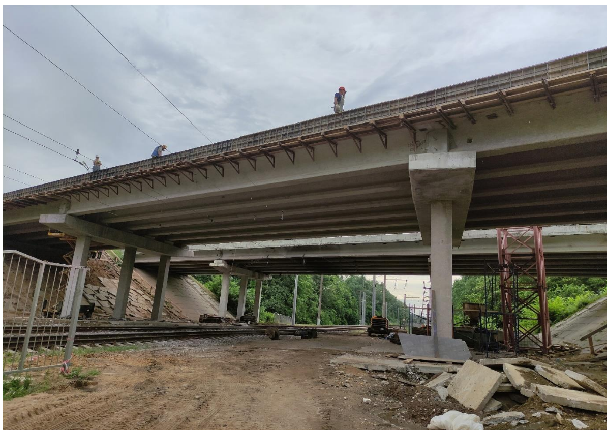
Рисунок 1 – Реконструированный путепровода через железные пути
