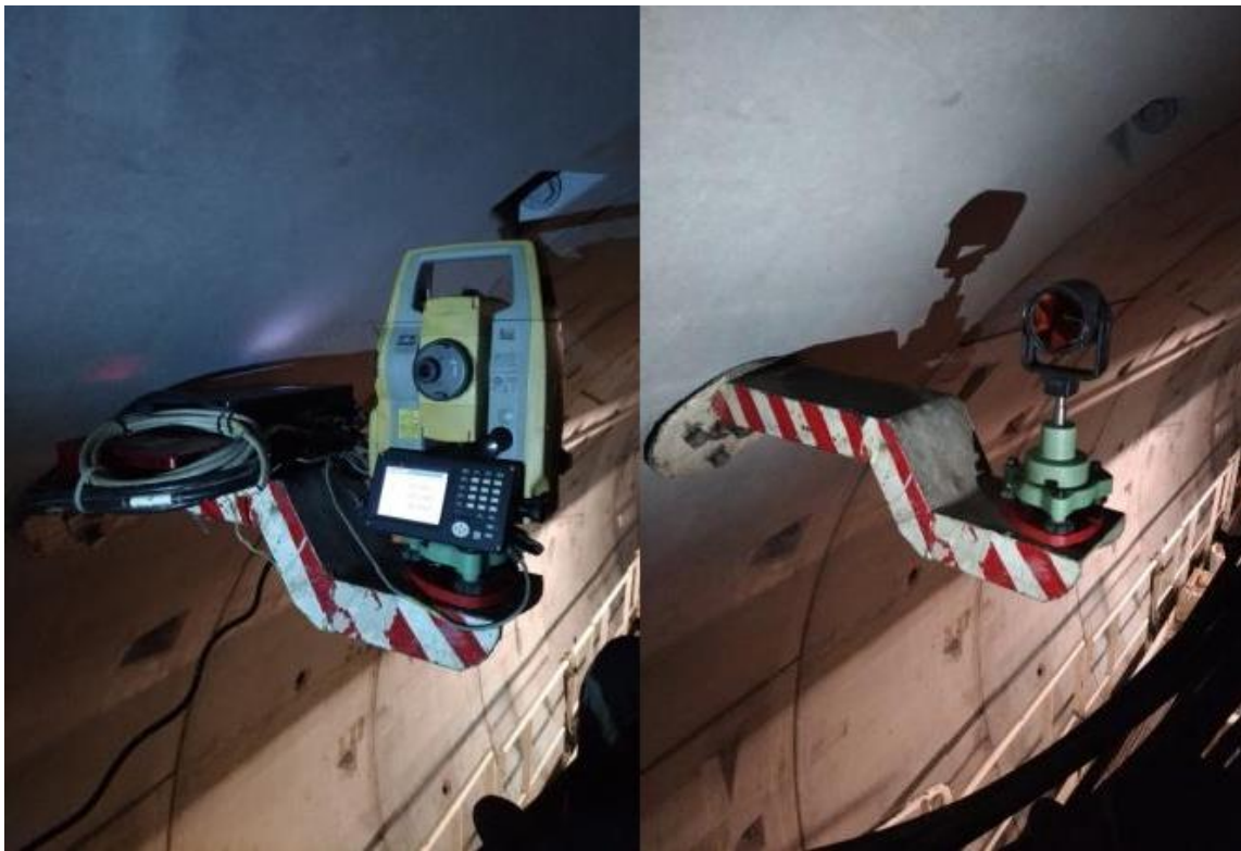
Рисунок 5 – Тахеометр и призма на консоли
