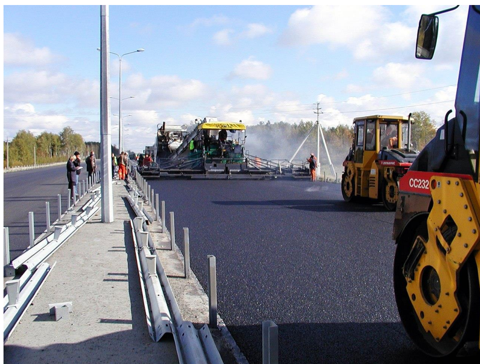
Рисунок 2 – Процесс строительства дороги по методу Superpave
