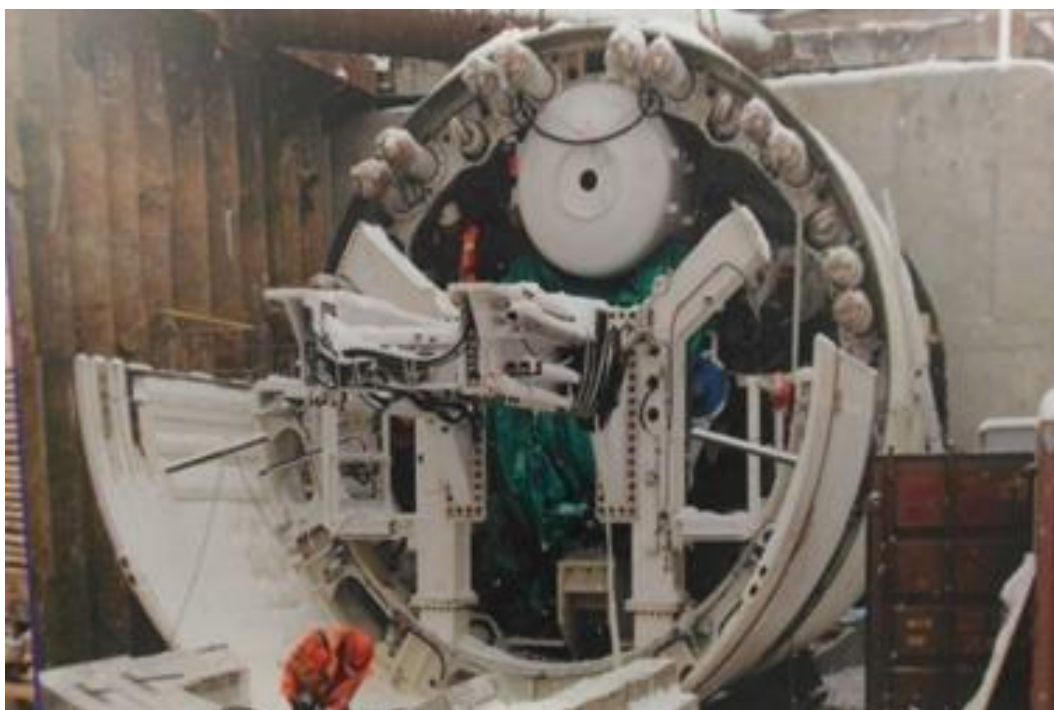
Рисунок 1 – Смонтированный ТПМК «Алеся» на ложе
