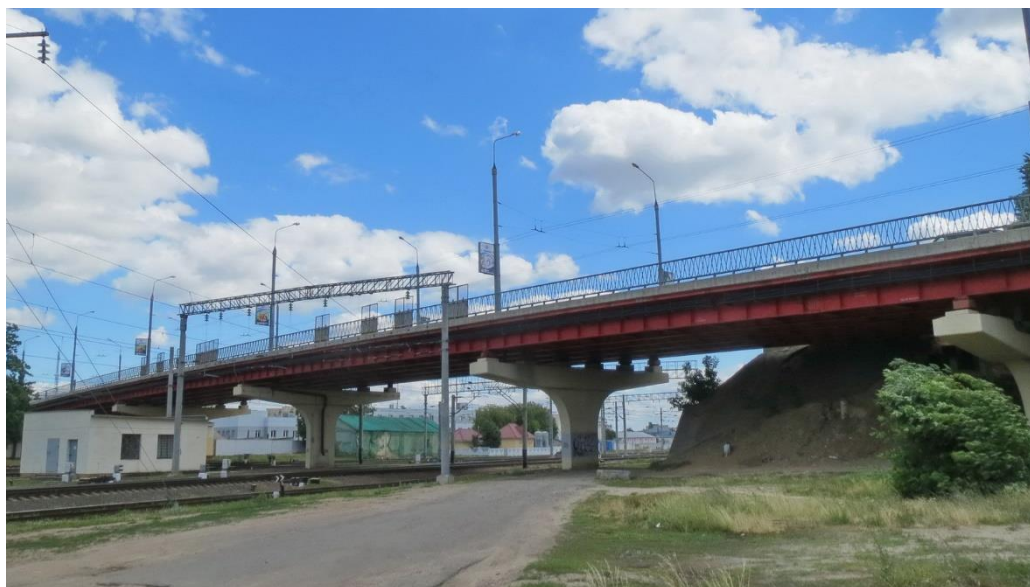
Рисунок 3 – Путепровод в г. Гомеле
