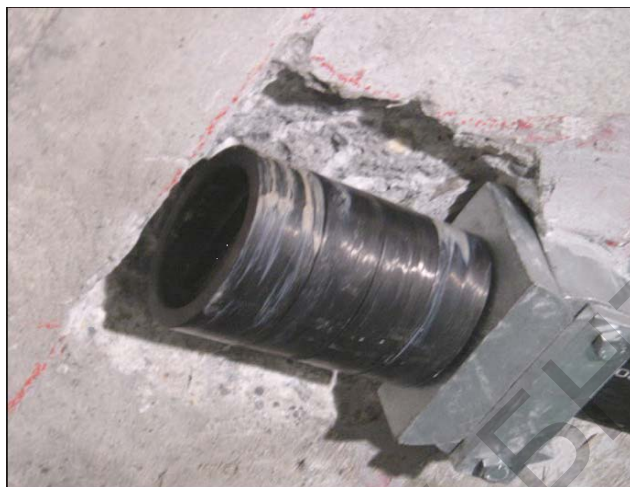
Рисунок 1 – Анкеровка углеродной ленты
