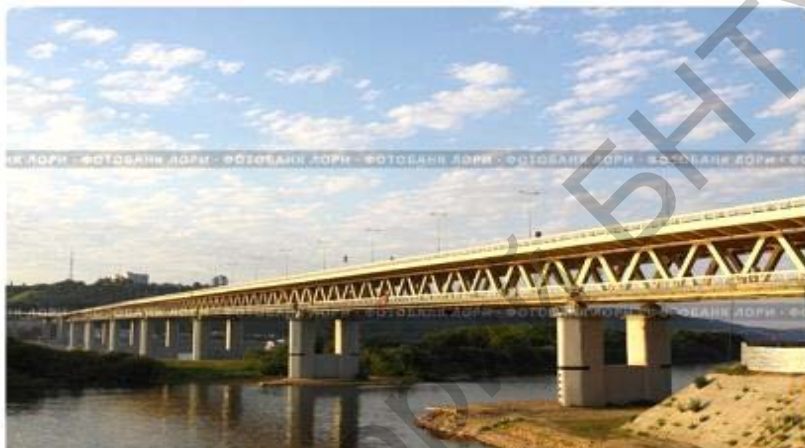
Рисунок 1 – Общий вид моста.
