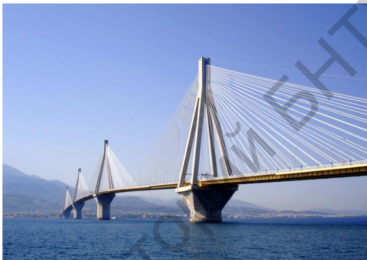
Рисунок 1 – Общий вид моста
