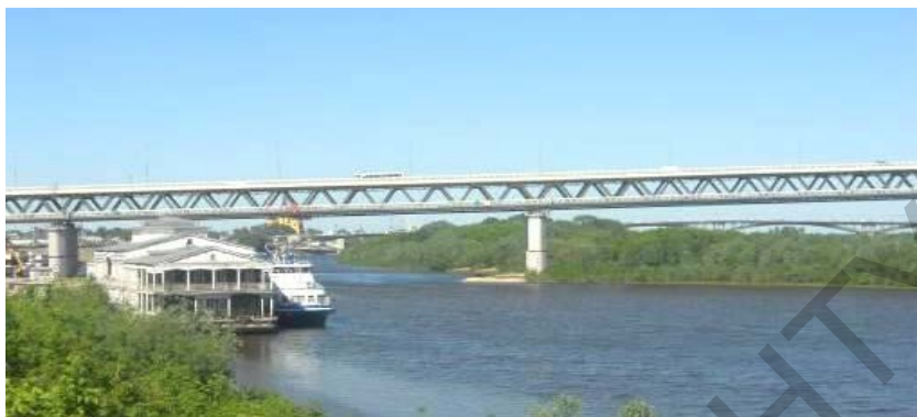
Рисунок 2 – Общий вид моста с другого берега.
