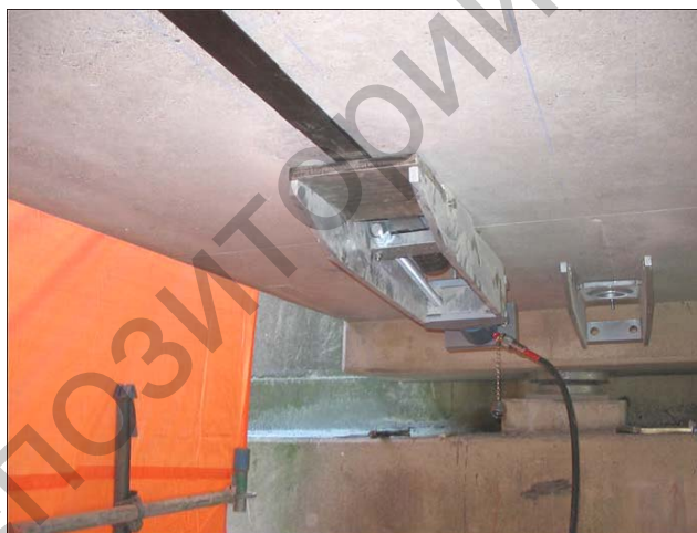
Рисунок 2 – Система для натяжения углеродной ленты
