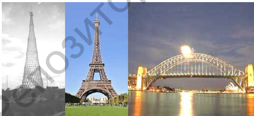
Рисунок 2 – Сооружения возведённые при помощи заклёпок
