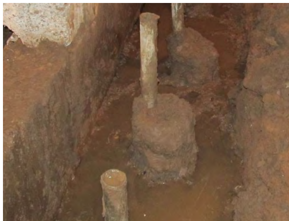
Рис. 4. Общий вид винтовых свай после откопки
