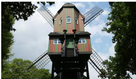
Рис. 2 – Мельница 1809 года постройки, Северный Рейн-Вестфалия
